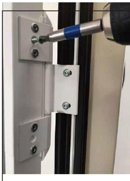
6. 从门的底部开始将配件中的加固垫圈（编号 A3363）延门边将整圈安装好。
