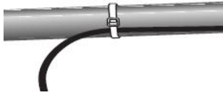
图 8.3 将电缆绑在顶部支架上
